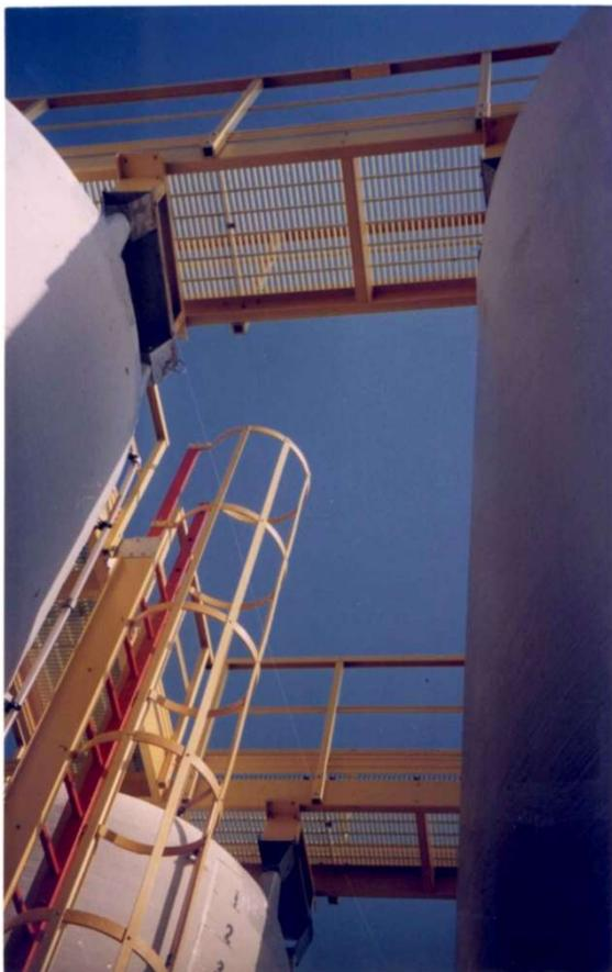
I parapetti realizzati con profili pultrusi in resina poliesteri isoftalica e fibre di vetro offrono una notevole serie di vantaggi rispetto ai normali parapetti metallici.
