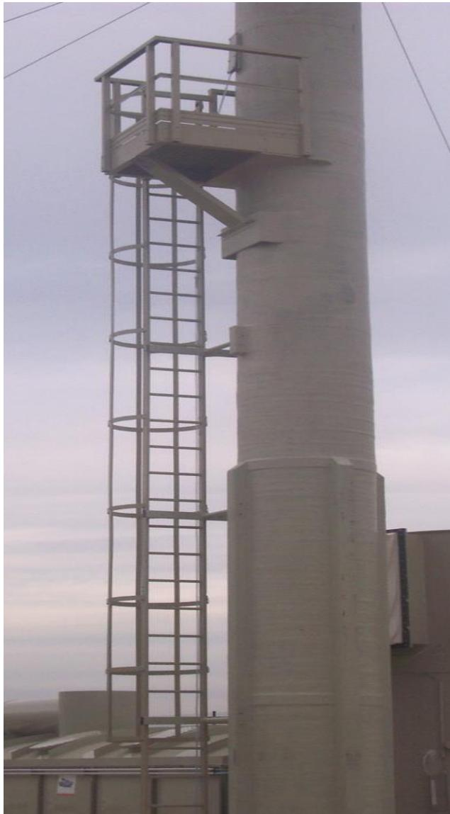
Las escaleras verticales de M.M. S.r.l., realizadas con perfiles de resina isoftálica y fibras de vidrio, ofrecen una importante serie de ventajas con respecto a las normales escaleras metálicas:
